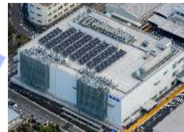
屋上の太陽光パネル
